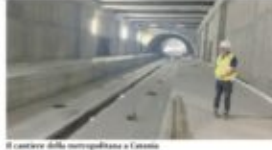
Il cantiere della metropolitana a Catania
