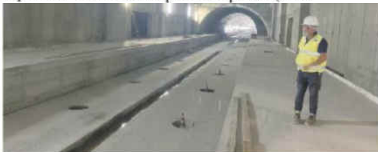
Il cantiere della metropolitana a Catania
